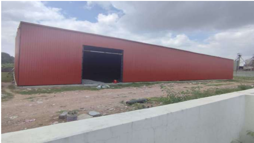
నాగారం మున్సిపల్ పరిధిలో టౌన్ ప్లానింగ్ అధికారులు, కమిషనర్ ఏకమై అక్రమ నిర్మాణాలు, అక్రమ షెడల్ నిర్మాణాలు చేయించడమే ద్వారాగా మారినది స్థానికులు ఆరోపిస్తున్నారు. జిల్లా కలెక్టర్ స్పందించి నాగారం మున్సిపల్ పరిధిలో జరుగుతున్న అక్రమ షెడల్ నిర్మాణాలపై చర్యలు తీసుకోవాలని స్థానికులు కోరుతున్నారు.
